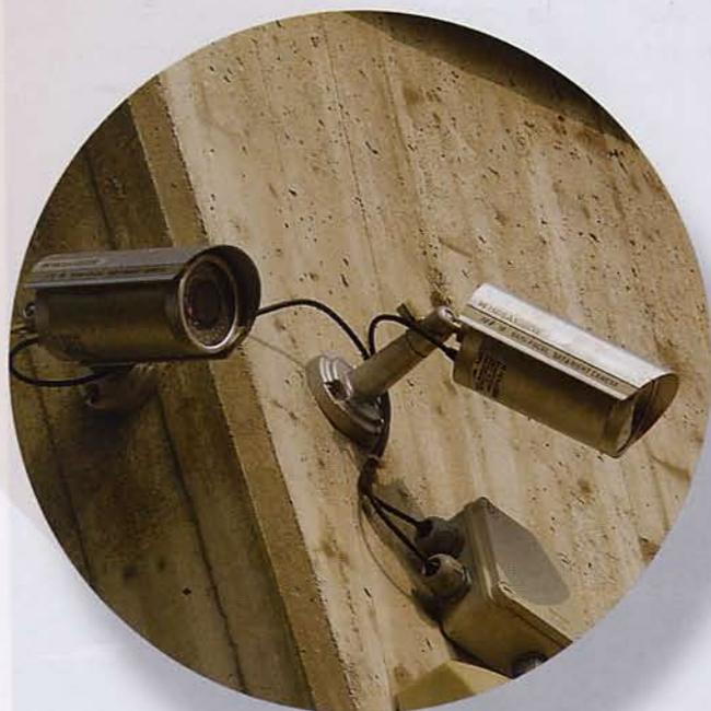
a un'ulteriore copertura perimetrale. In aggiunta, sono presenti più sirene interne ed esterne. In caso di allarme, il sistema lancia messaggi istantanei con tipologia di allarme su ogni supervisore. Un combinatore telefonico standard effettua chiamate vocali e invia sms con la tipologia dell'avvenimento su cellulari, numeri fissi e Forze dell'Ordine.
